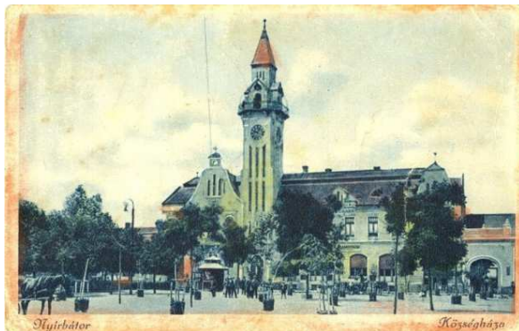
A községháza neogótikus épülettömbje
