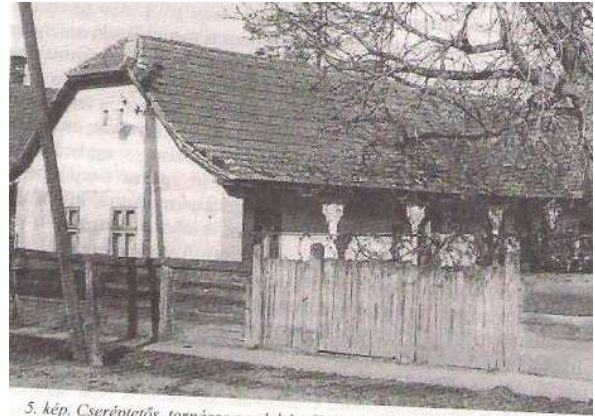
5. kép. Cseréptető, tornácos gazdaház, fűrészelt díszítésű oszlopfejekkel (Árpád u. 16.)
