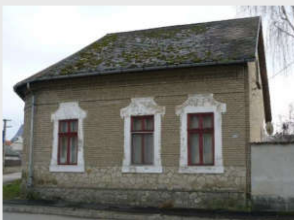
Lakóház (Váradi u. 1.)
