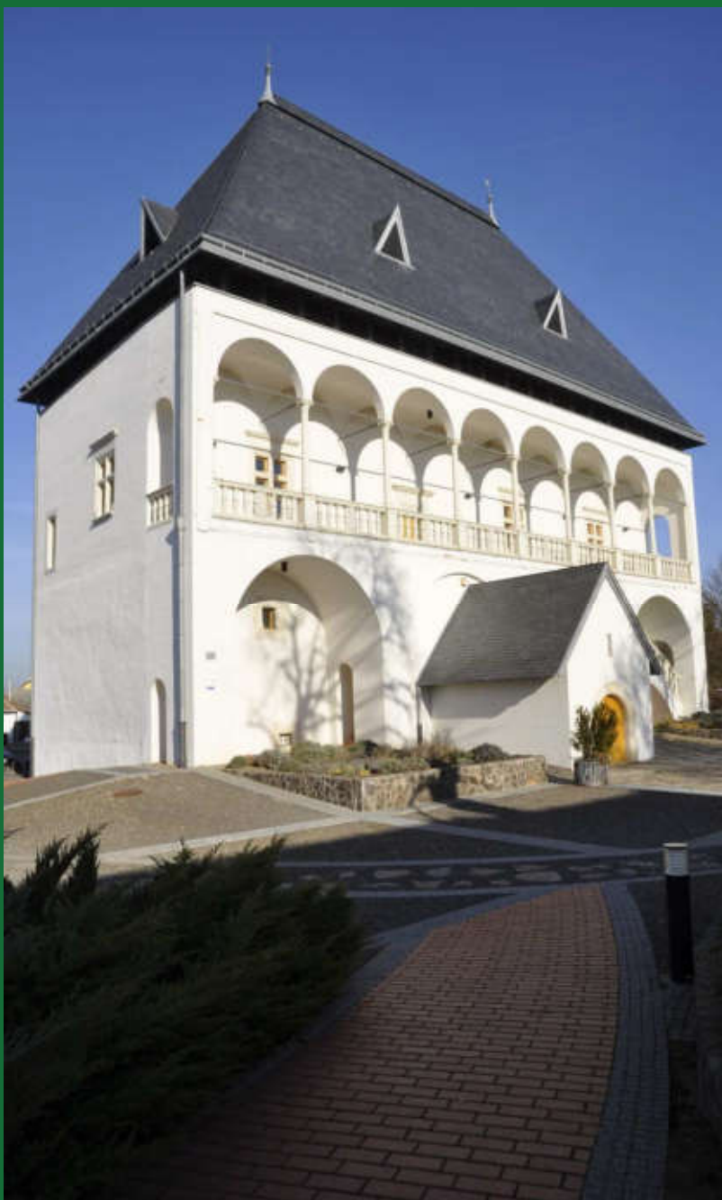
„Báthori Várkastély és Panoptikum rekonstrukció után”
