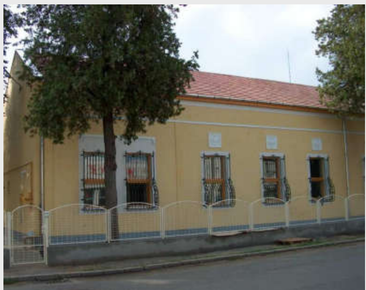
„Alkotóház felújítás után”
