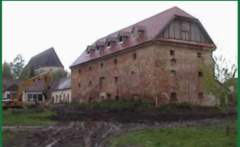
„Báthori Várkastély és Panoptikum a rekonstrukció előtt”
