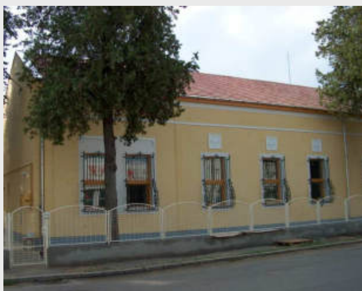
„Alkotóház felújítás után”
