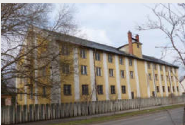
Dohánygyári épületek (Madách u. 32.)
