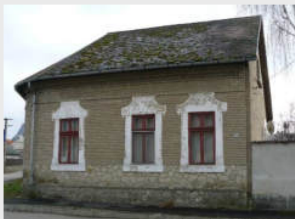
Lakóház (Váradi u. 1.)
